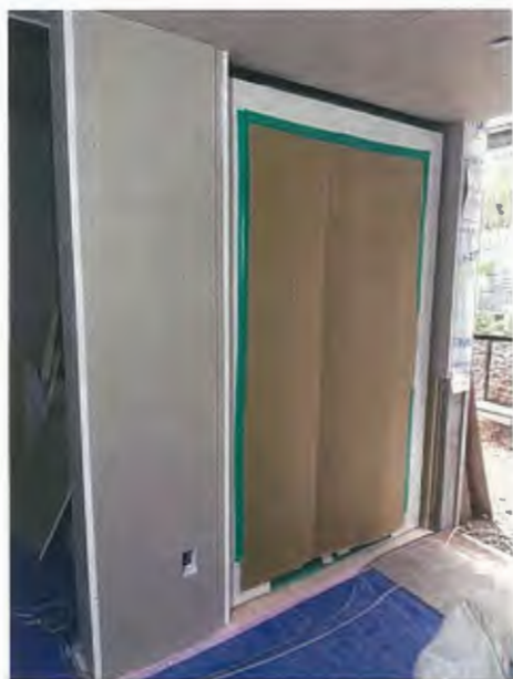
エレベーターが設置されました。
